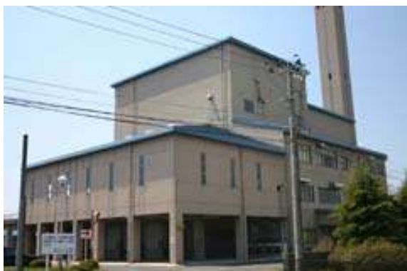
写真1 角田衛生センター
