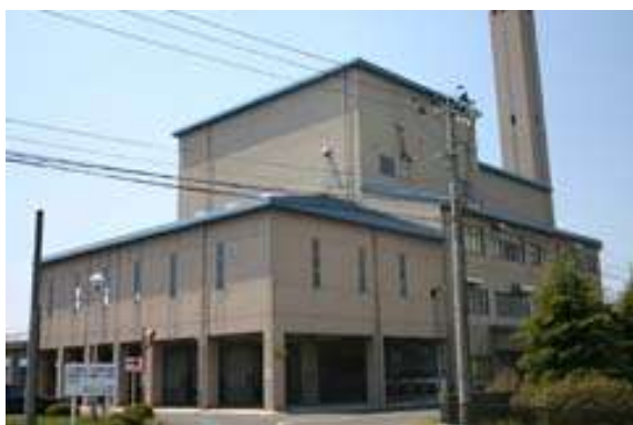
写真1 角田衛生センター
