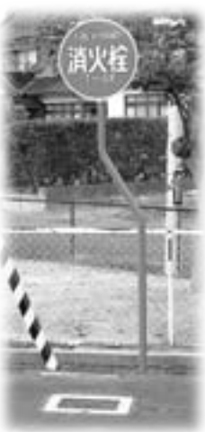
消火栓(上写真) 地下式消火栓 (左写真)
