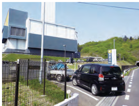
▲持込ごみの増加で、廃棄物搬入口まで大渋滞が発生している仙南クリーンセンター
