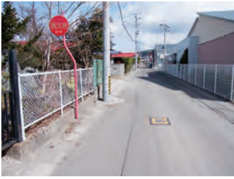
▲地下式消火栓
