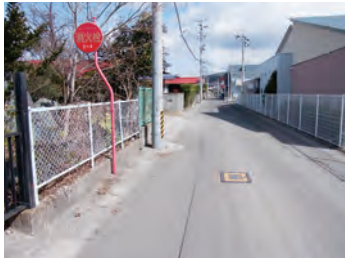
▲地下式消火栓
