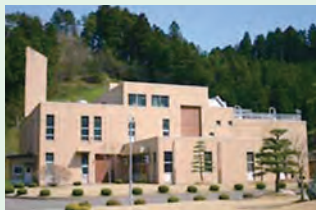
▲柴田衛生センター (昭和60年10月供用開始)
