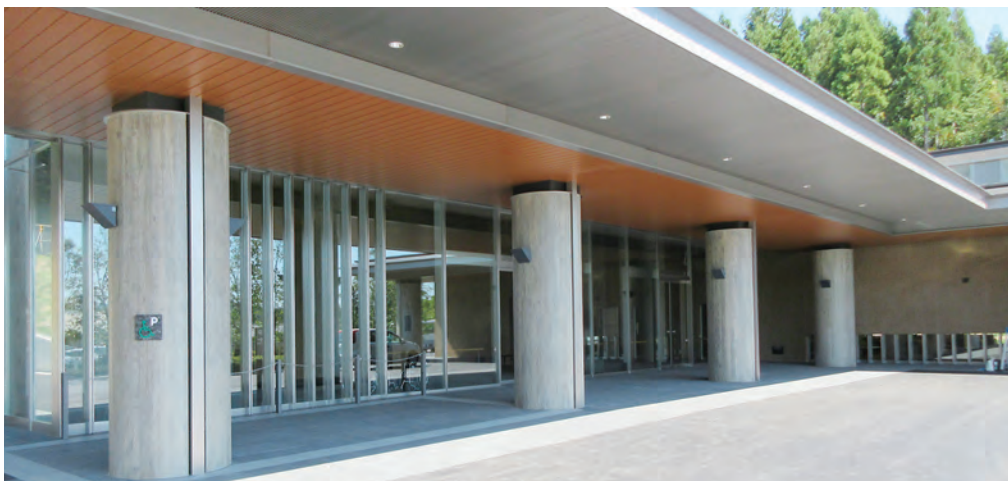
▶ 白石斎苑正面入口
