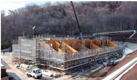
▶ 白石斎苑の建築工事状況（2月時点）
