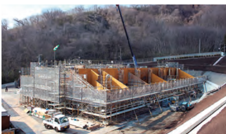
▶ 白石斎苑の建築工事状況（2月時点）
