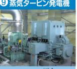
ボイラでつくった蒸気でター ビン発電機を回して電気を つくります。
